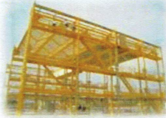
屋根付リーファース設備全景
